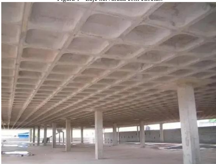
Figura 1 - Laje nervurada com cubetas.
