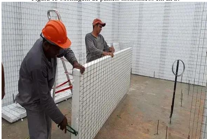
Figura 13 Montagem de painéis monolíticos em EPS.
