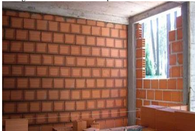
Figura 02 Alvenaria de vedação com bloco cerâmico.
