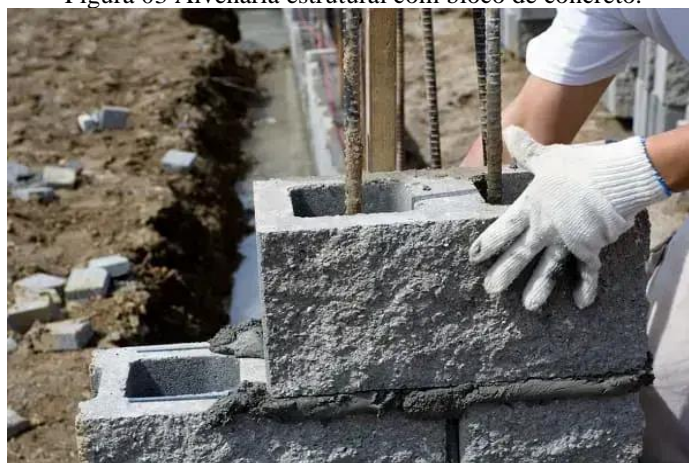
Figura 03 Alvenaria estrutural com bloco de concreto.
