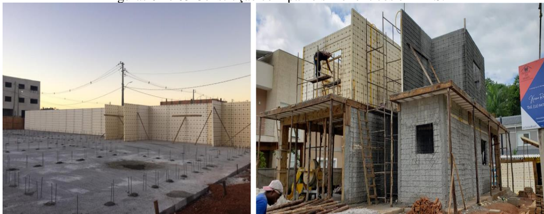
Figuras 04 e 05 Construção com painéis monolíticos em EPS.
