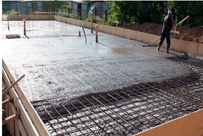
Figura 01 Laje em concreto armado.
