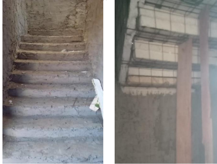
Figura 27 – Escadaria em EPS rebocada (à esq.), com detalhe para escoramento da mesma (à dir.)
