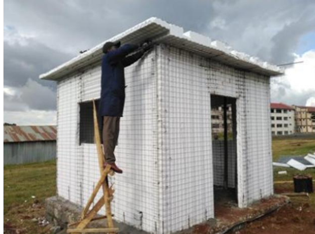
Figura 3 – Exemplo de construção utilizando o sistema construtivo em EPS no Quênia
