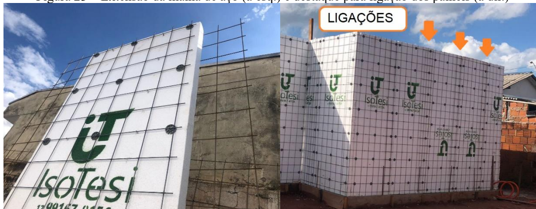
Figura 23 – Extensão da malha de aço (à esq.) e destaque para ligação dos painéis (à dir.)
