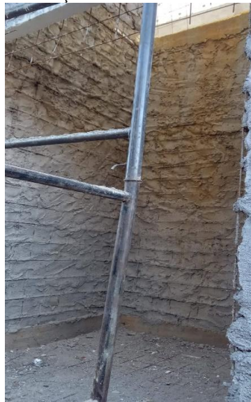
Figura 28 – Poço do elevador em fase de reboco
