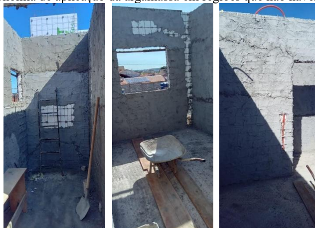
Figura 32 – Economia de aplicação da argamassa em regiões que não haverá o revestimento
