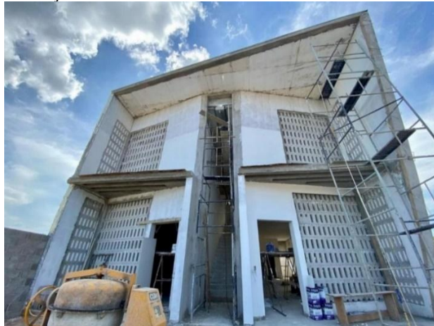
Figura 5 – Construção utilizando o sistema em ICF realizada no Nordeste do Brasil
