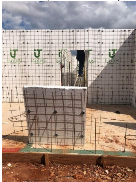
Figura 19 – Radier já concretado e marcação de cores
