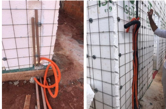
Figura 24 – Passagem de tubulações pela fundação (à esq.) e chegada dos eletrodutos no painel em EPS (à dir.)
