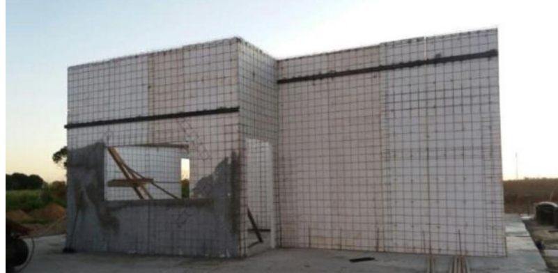
Figura 1 – Exemplo de construção utilizando o sistema construtivo em EPS
