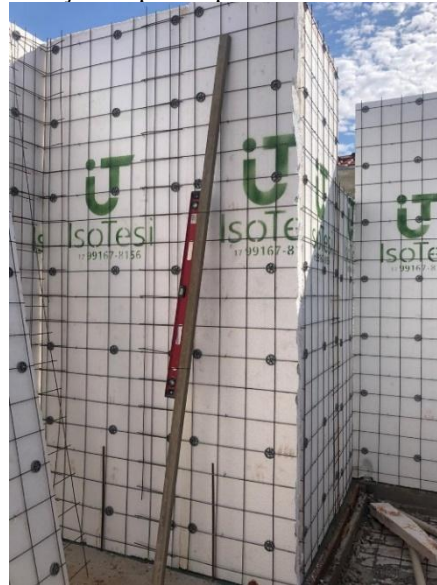
Figura 22 – Utilização do prumo para nivelamento do painel em EPS
