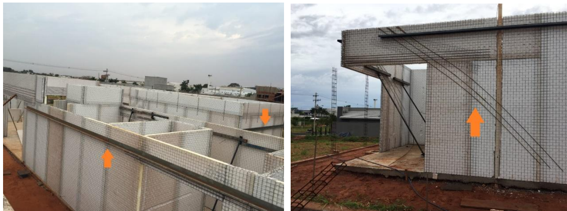
Figura 18 – Utilização de longarinas metálicas (à esq.) e vergalhões de aço (à dir.) para alinhamento horizontal dos painéis de EPS
