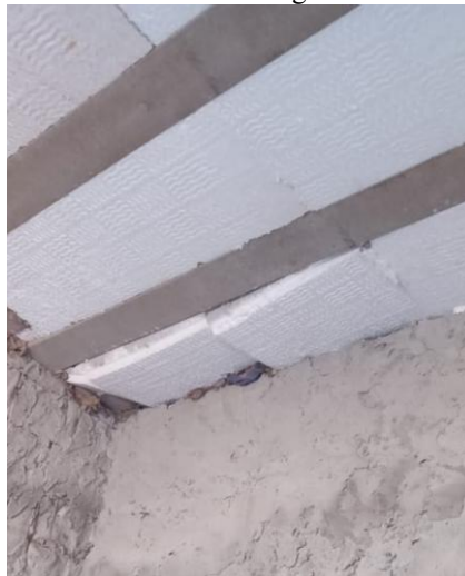
Figura 30 – Placa de EPS com sobrecarga de concreto no canto da laje
