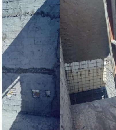
Figura 31 – Fase de reboco com argamassa estrutural (à esq.) e tradicional (à dir.)
