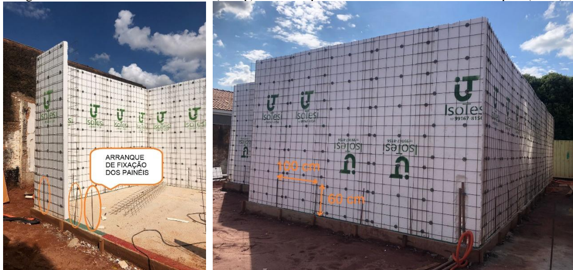
Figura 20 – Painéis em EPS fixados (à esq.) e detalhe para distanciamento entre os arranques (à dir.)
