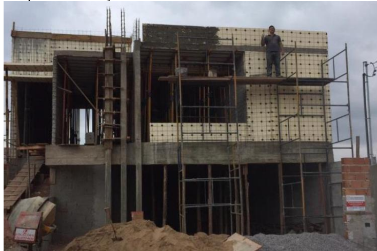
Figura 2 – Exemplo de construção utilizando o sistema construtivo em EPS em Varginha/MG
