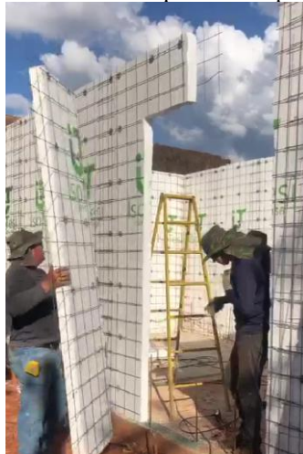
Figura 21 – Abertura de esquadrias no painel em EPS
