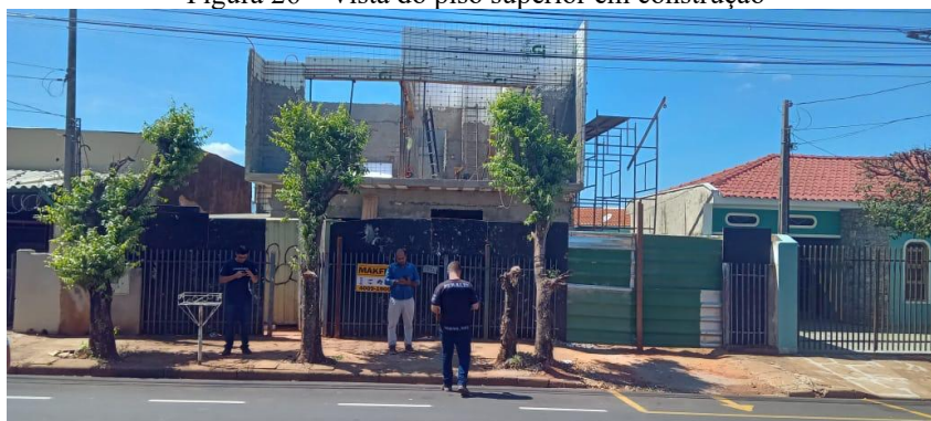
Figura 26 – Vista do piso superior em construção
