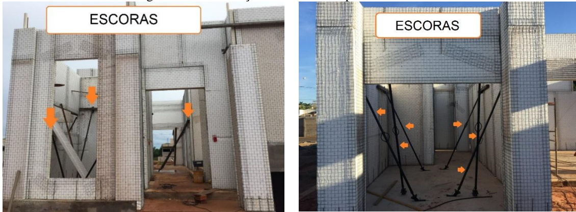
Figura 17 – Construção em EPS na etapa de escoramento
