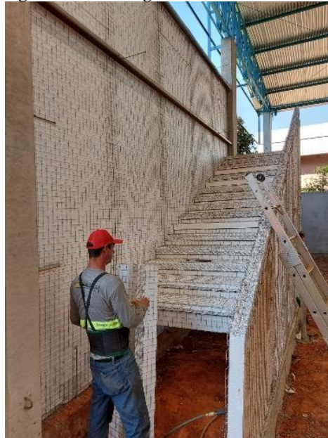
Figura 17 – Montagem da escadaria em EPS
