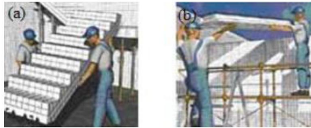
Figura 18 – Montagem da escadaria (à esq.) e da laje (à dir.)
