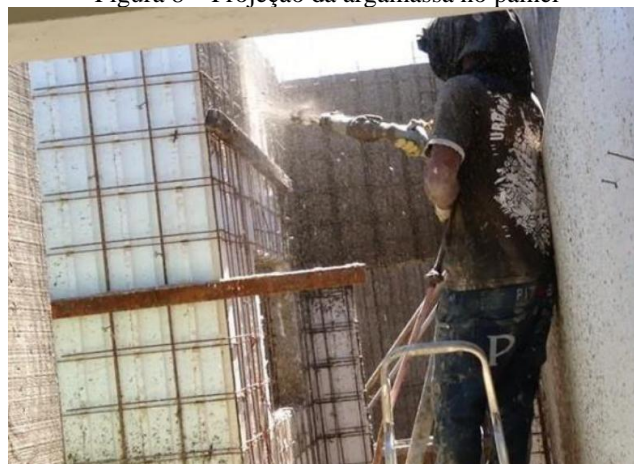
Figura 8 – Projeção da argamassa no painel
