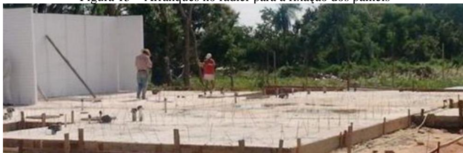
Figura 15 – Arranques no radier para a fixação dos painéis
