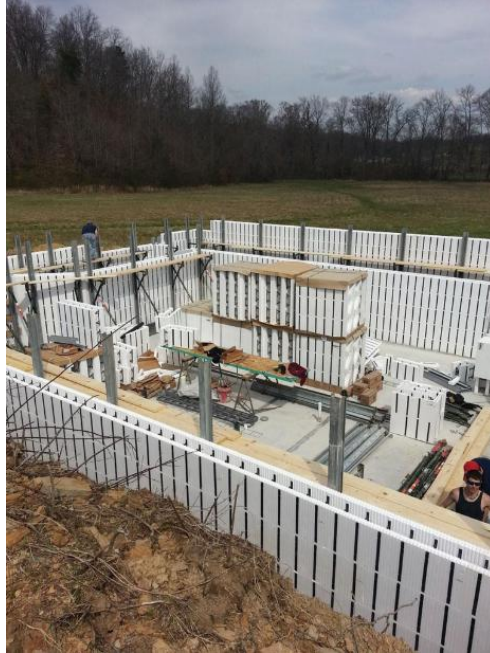
Figura 4 – Construção utilizando o sistema em ICF
