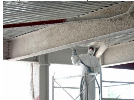
Figura 13 – Jateamento de perfil metálico
