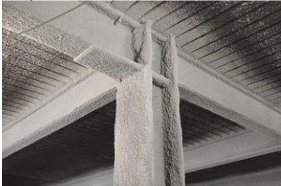
Figura 12 – Estrutura de aço revestida com argamassa reforçada com fibras.
