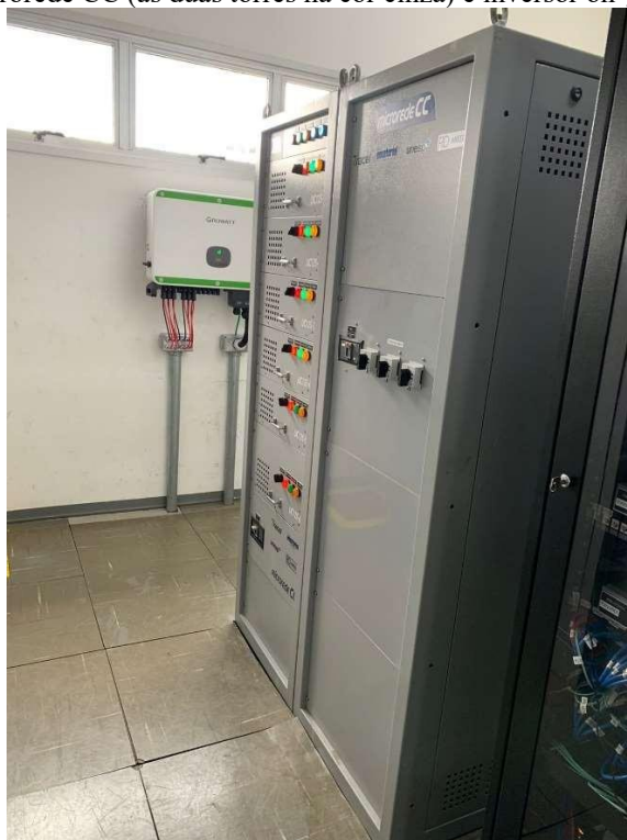
Figura 13 - Sistema microrede CC (as duas torres na cor cinza) e inversor on-grid comercial (ao fundo)
