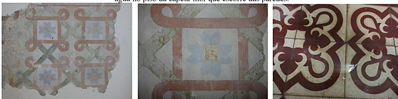
Figura 13: (esquerda) – Ataque intenso por umidade provocando desbotamento, amarelamento e descolamento da pintura. (centro) – Detalhe do desaparecimento da cor verde das faixas dos losangos diagonais (quadrados) e presença de esbranquiçamento (sabonificação) nos laçarotes vermelhos devido ao ataque por sais solúveis. (direita) – Presença de água no piso da capela-mor que escorre das paredes.
