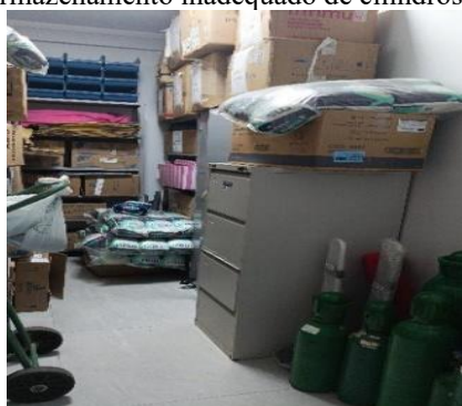
Figura 4. Armazenamento inadequado de cilindros de oxigênio
