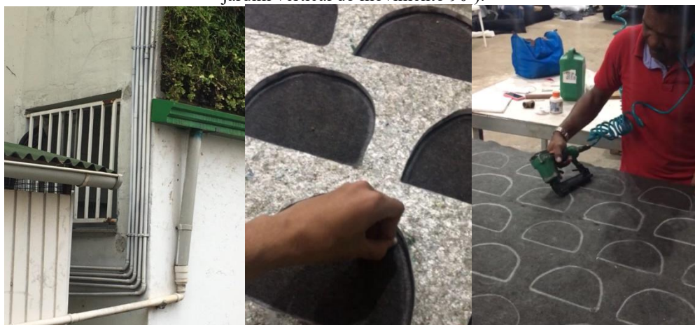
Figura 12, 13 e 14 respectivamente: Sistema de irrigação e drenagem do sistema de jardim vertical Ed. Huds, minhocão, São Paulo-SP; Molde bolsos a serem grampeados e Bolsos sendo grampeados por colaborador da empresa (Sistema de jardim vertical do movimento 90°).
