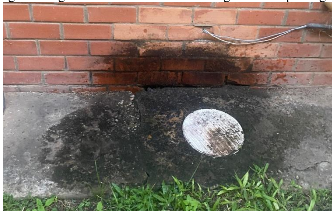
Figura 4. Água descartada incorretamente gera lodo e patologias.
