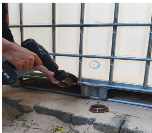
Figura 10 (C). Marcação das estradas e saídas do reservatório
