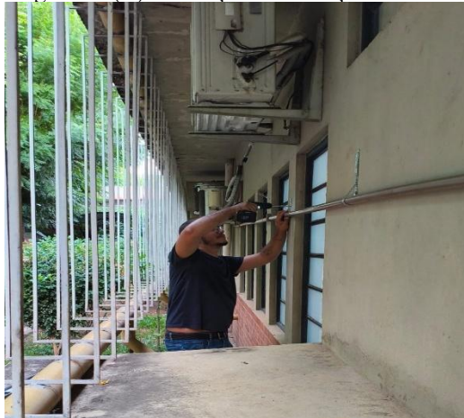
Figura 10 (B). Instalação da tubulação de coleta
