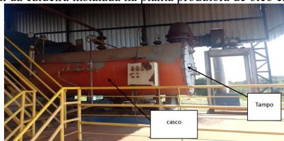
Figura 2. Vista geral da caldeira instalada na planta produtora de óleo essencial de citronela.
