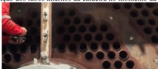
Figura 8. Condição dos tubos internos da caldeira no momento da inspeção visual.
