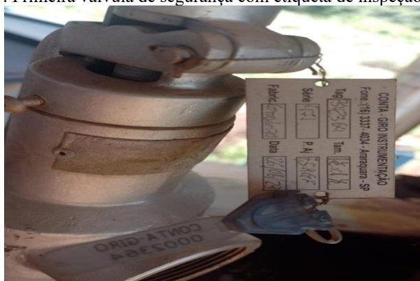
Figura 9. Primeira válvula de segurança com etiqueta de inspeção vencida.
