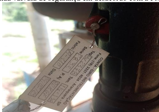
Figura 10. Segunda válvula de segurança em desacordo com a PMTA estabelecida.
