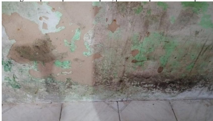
Figura 04 – Patologia na parede próximo do piso, provocada por umidade e presença de bolores
