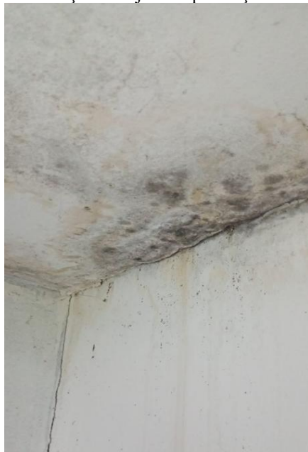
Figura 03 – Patologia de infiltração na laje com presença de bolores no teto e na parede
