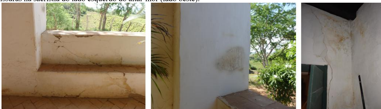
Figura 8: (esquerda) – Umidade nos bancos do avarandamento da fachada oeste. (centro) – Detalhe de infiltrações, mancha de umidade parede avarandamento fachada oeste. (direita) – Detalhe de umidade por condensação acompanhada por fissuras na sacristia do lado esquerdo do altar-mor (lado oeste).
