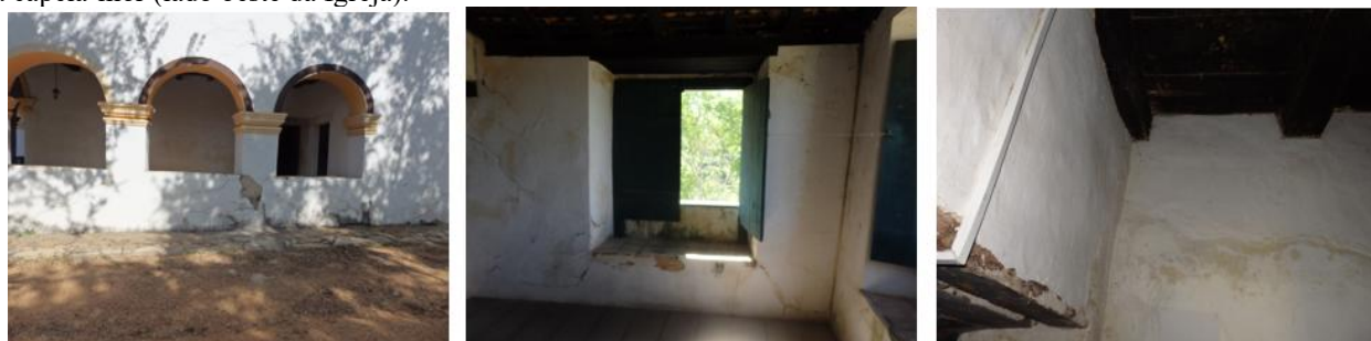
Figura 10: (esquerda) – Ataque por sais na fachada externa lateral oeste. (centro) – Ataque por sais na parede lateral oeste parte superior (galerias acima do avarandamento). (direita) – Ataque por sais na parede interna da Sacristia do lado esquerdo da capela-mor (lado oeste da Igreja).
