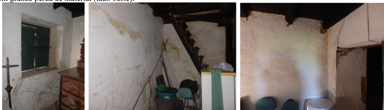
Figura 9: (esquerda) – Parede lateral interna da sacristia do lado direito do altar-mor (umidade condensação). (centro) – Parede atrás do altar-mor com alta concentração umidade condensação. (direita) – Detalhe da parede interna da sacristia do lado esquerdo do altar, umidade condensação acompanhada por uma das maiores fissuras encontradas na edificação, com grande perda de material (lado oeste).
