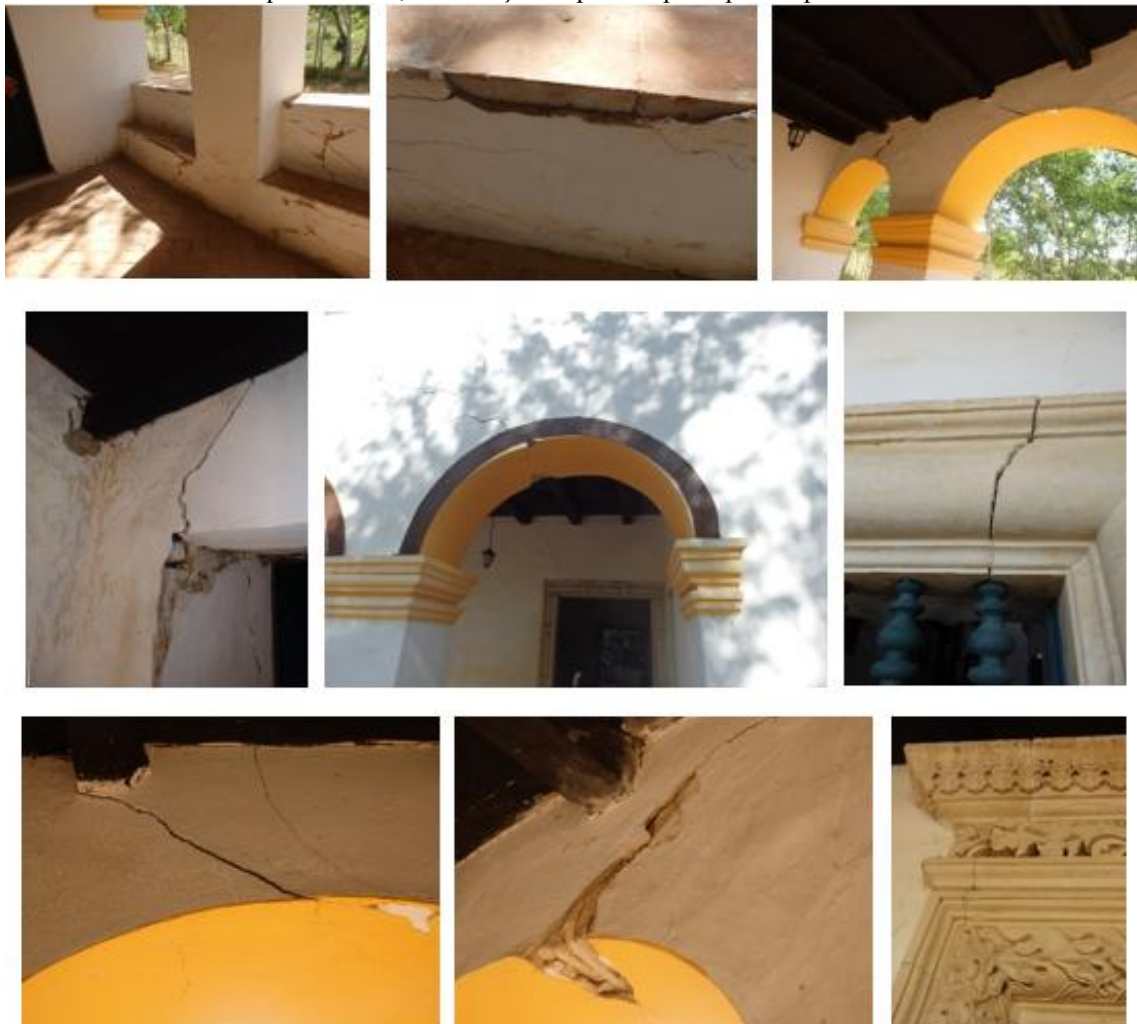
Figura 11: (acima - da esquerda para a direita) – Desagregações, esmagamento e fendilhações nos bancos e arcos do avarandamento da parede oeste. (centro - da esquerda para a direita) – Esmagamento e fendilhações na porta da sacristia; em um dos arcos do avarandamento com estabilização, ambos na parede oeste; fendilhação na pedra calcária da janela ao lado da portada principal. (abaixo - da esquerda para a direita) – Fendilhações com desagregação e esmagamento no centro dos arcos do avarandamento da parede oeste; fendilhação na portada principal em pedra calcária.
