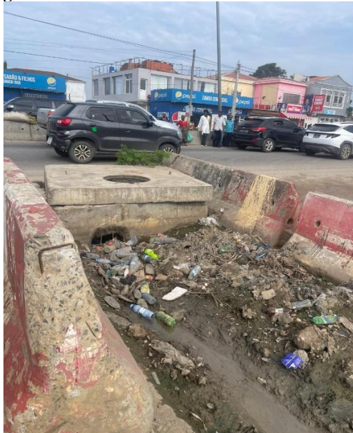
Figura 13 - Assoreamento de caixa de visita no local
