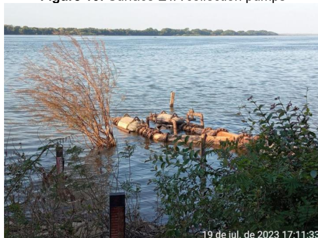
Figure 10: Surface ETA collection pumps
