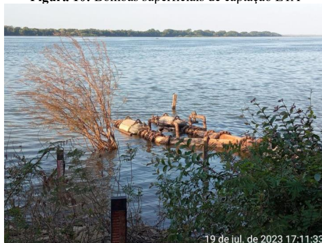
Figura 10: Bombas superficiais de captação ETA
