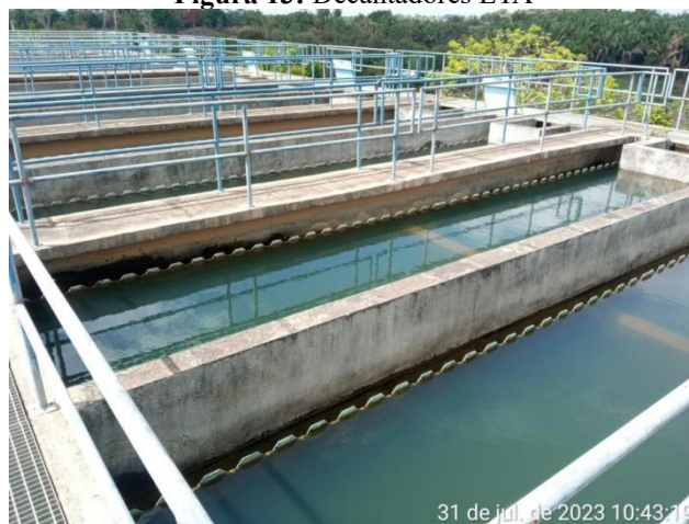
Figura 13: Decantadores ETA
