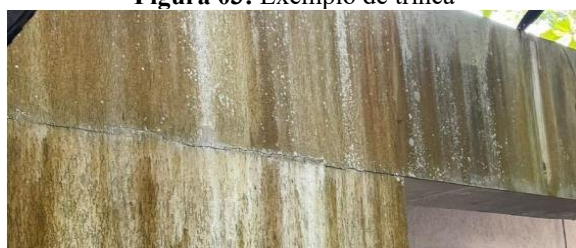
Figura 03: Exemplo de trinca
