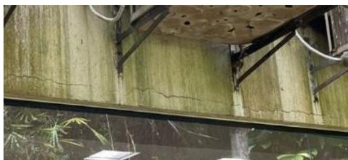
Figura 04: Exemplo de rachaduras
