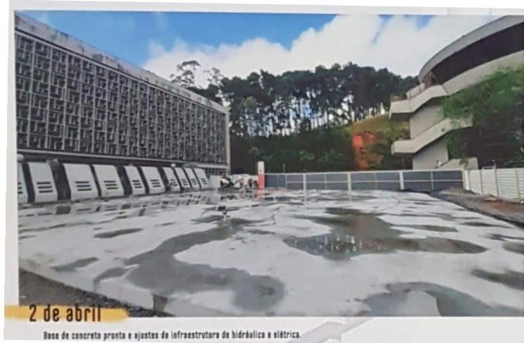
Figura 25 – Preparação de estrutura rasa (radier) para recebimento dos módulos (02/04/2020)
