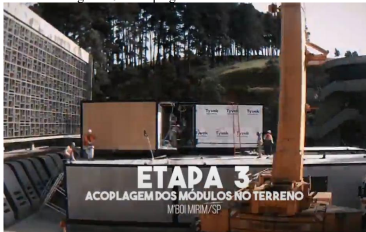
Figura 26 – Acoplagem dos módulos no local
