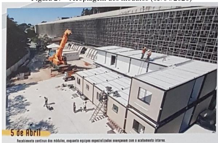
Figura 27 – Acoplagem dos módulos (05/04/2020)
