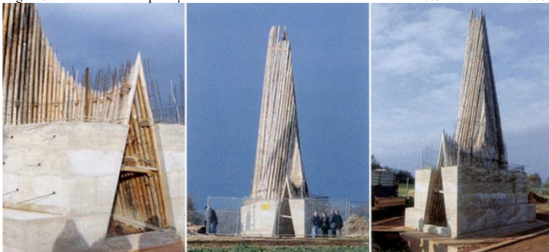
Figura 5 – Processo de compactação das camadas de concreto entre outubro de 2005 e setembro de 2006.
