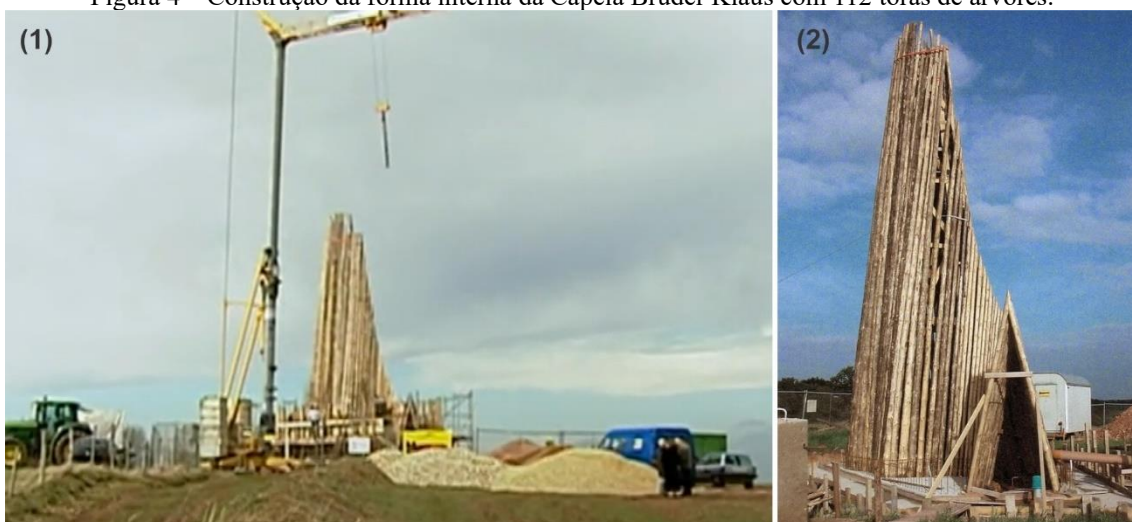
Figura 4 – Construção da fôrma interna da Capela Bruder Klaus com 112 toras de árvores.
