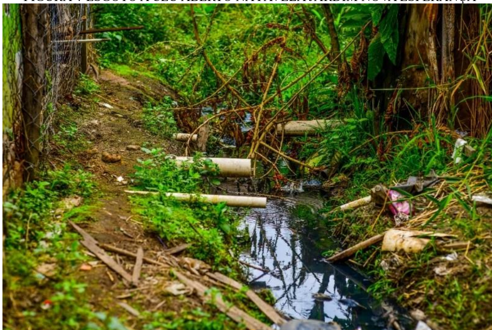
FIGURA 4-ESGOTO A CÉU ABERTO NA FAVELA JARDIM NOVA ESPERANÇA
