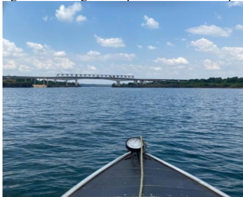
Figura 2. Vista geral da ponte antes do colapso.
