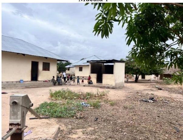
Figura 05 – Casa e cozinha exterior construídas pelo Corredor de Nacala para as famílias reassentadas, Comunidade de Mucaia 1
