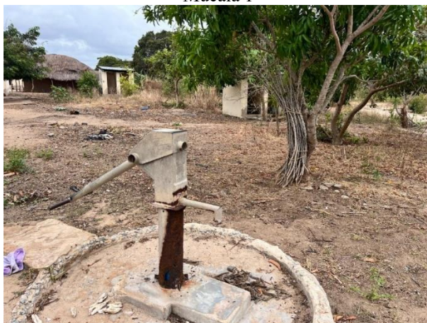
Figura 06 – Fontenária (em desuso) construída pelo Corredor de Nacala para as famílias reassentadas, Comunidade de Mucaia 1
