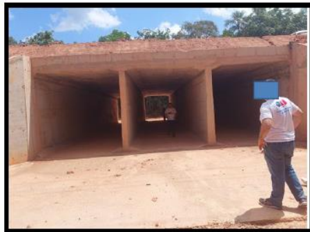
Figura 1. Passagem de Fauna localizada no Km 205 da BR-319(Trecho do Meio)
