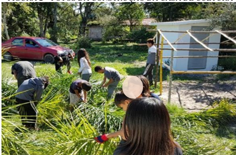
FIGURA 2 – FOTOS DA CONSTRUÇÃO DA CASA DE CULTURA
