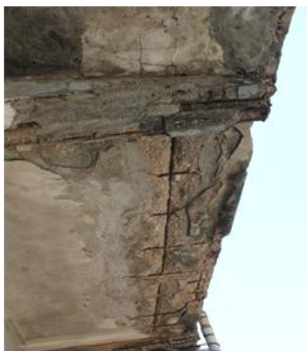
b) Destacamento do betão, exposição e corrosão do aço das varandas
