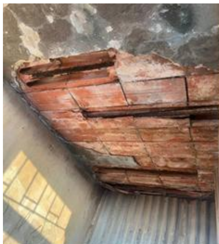
b) Destacamento do betão, exposição e corrosão do aço das varandas
