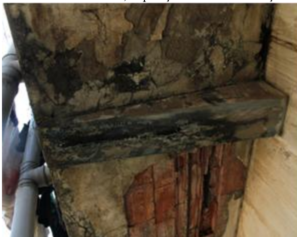
c) Infiltração nas lajes das varandas em consola
