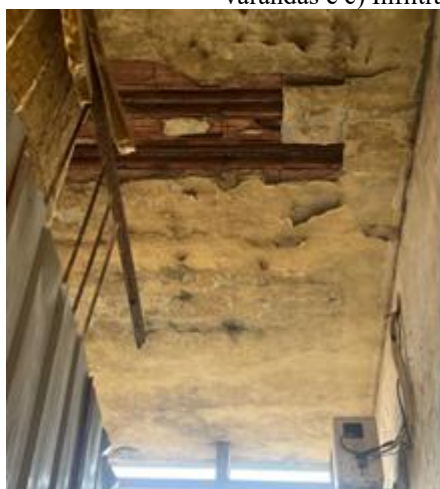
Fissuras e degradação da caixa de escada
