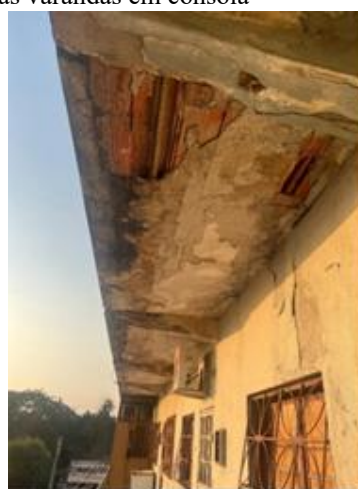
fissuras e deformação no pavimento e parede
