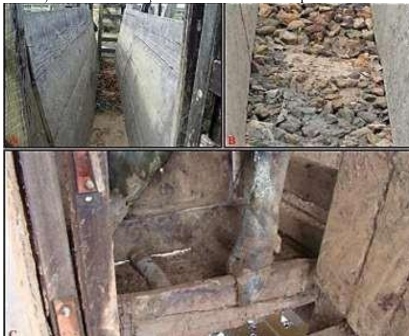
Figura 2. Instalação inadequada para bovinos de corte. A) Piso da seringa calçado com pedras; B) Detalhe da foto anterior; C) Troncos de contenção com tábuas laterais com quinas salientes.
