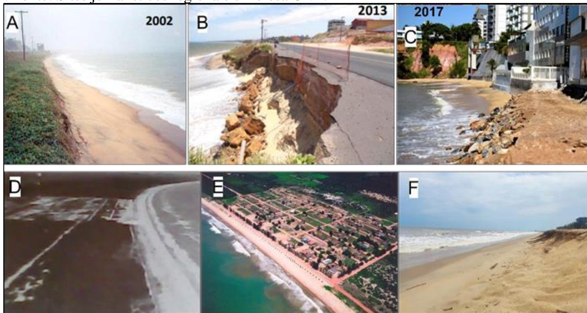
Figura 5: Ilustração de diferentes regiões do estado do ES, com forte aspectos erosivo. (A) trecho de rodovia aterrado Anchieta-ES (B) Rodovia erodida pelas ondas na Praia de UBU (C) Praia da Areia Preta, Guarapari-ES (D) Praia das Neves em 1970 (E) Praia das Neves em 2013 (F) Praia das Neves em 2022. Fonte: Sites jornalísticos regionais e Defesa Civil.
