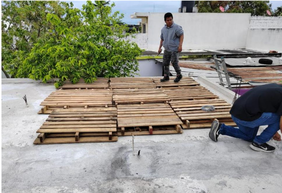
Figura 6. Zona experimental con la envolvente de Pallets instalados
