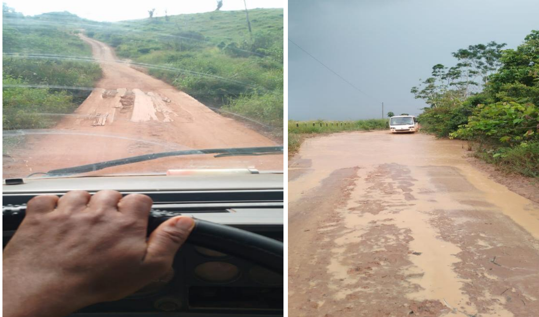
Figura 1- Estrada que dá acesso a Vicinal do Maxixe
