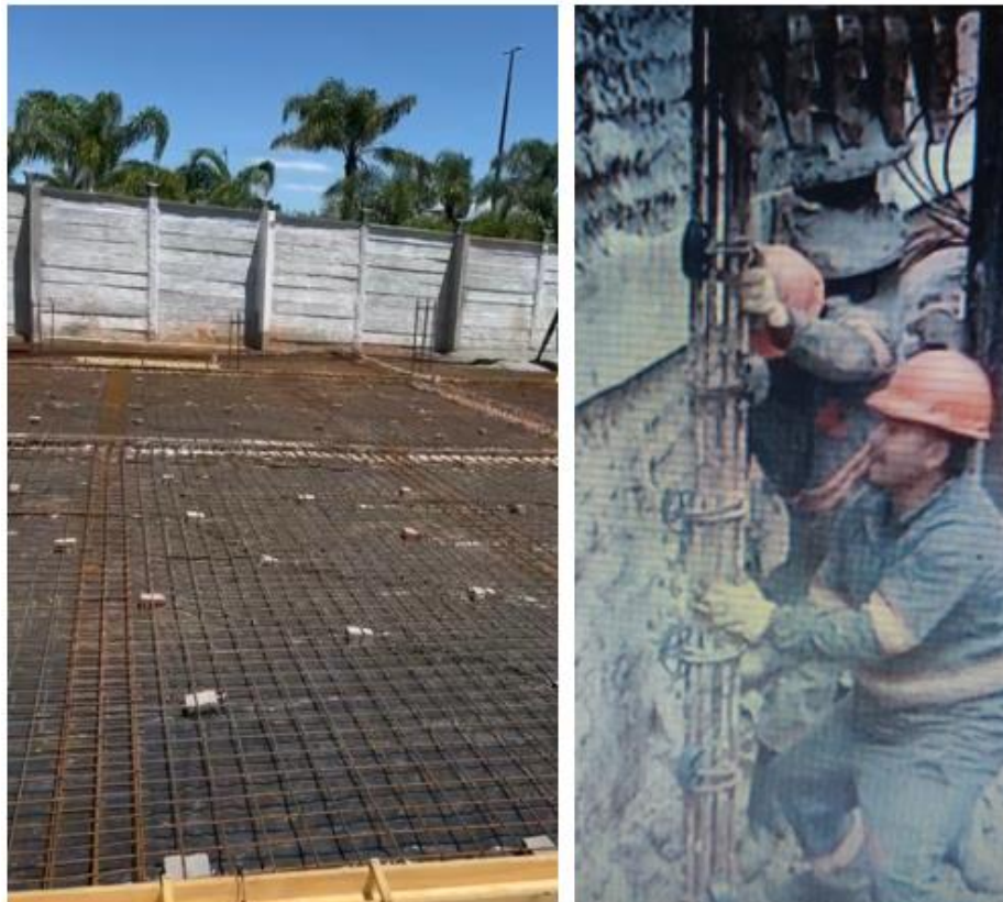
Figura 2 – Exemplos de execução de fundações com espaçadores.
