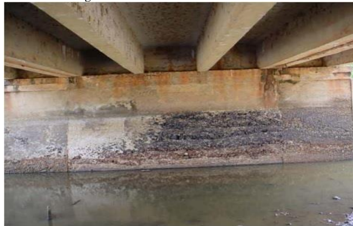
Figura 3 - Ponte do rio Titara BR-343/PI
