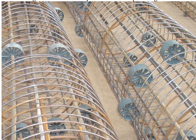
Figura 1 - Roletes de plástico na armação das gaiolas
