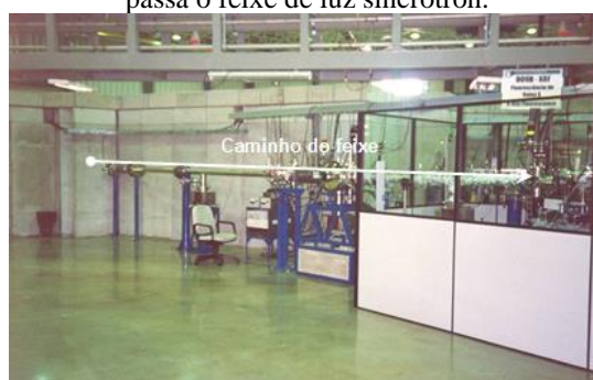
Figura 14 – Foto da tubulação do anel para a linha DO9B – XRF do Laboratório Nacional de Luz Síncrotron, por onde passa o feixe de luz síncrotron.
